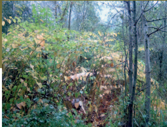
Digue envahie par la renouée Zone d'Anterne - commune de Vougy
